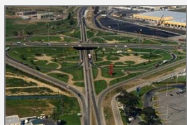
Autopista Concepción Talcahuano 1962
